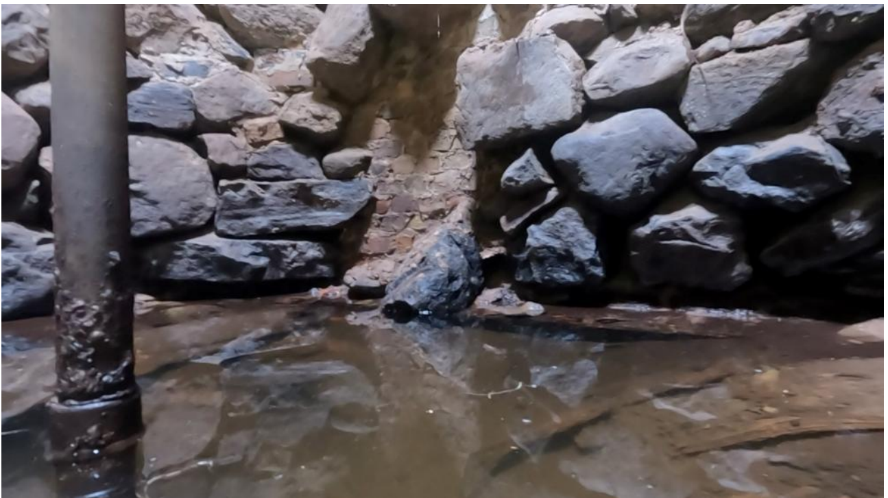
Zustand Mai 2023: Links vorn das Saugrohr der Schwengelpumpe. In Bildmitte Ausbesserungen der Brunnenwand mit Ziegelsteinmauerung (Foto: Maik Römhold)
