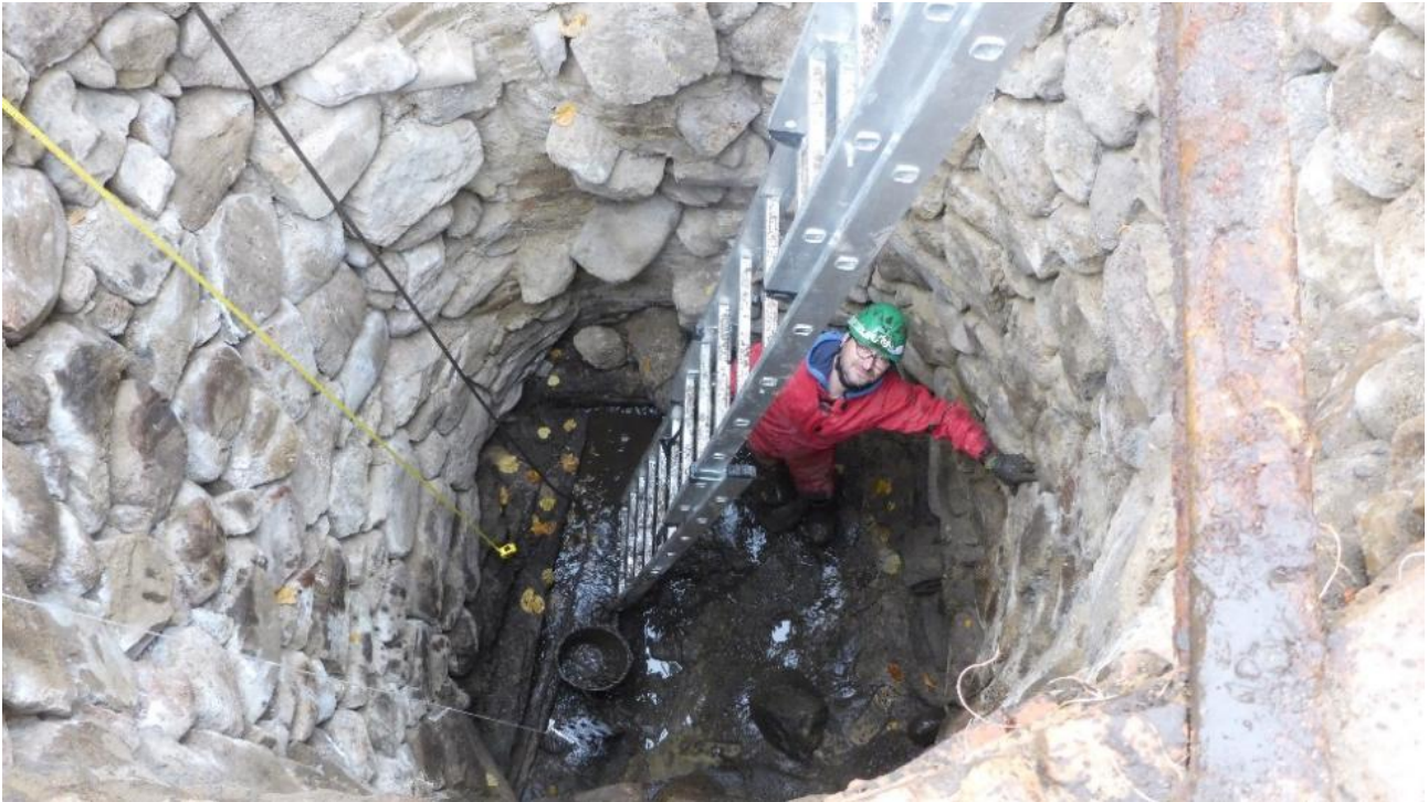
Nach dem Abpumpen des verbliebenen Wassers wird mit einem 10 l-Eimer mit archäologischer Sorgfalt ein Großteil des Faulschlammes geborgen (Foto: Hartmut Simmert)
