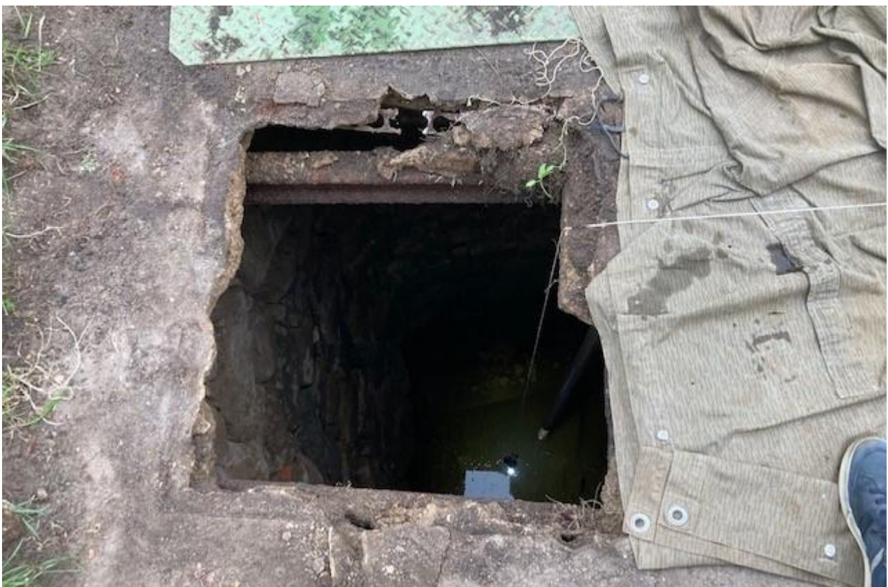
Die Revisionsöffnung wurde durch eine geteilte Abdeckplatte (Riffelblech) verschlossen, durch die ein Ansaugrohr geführt wurde und auf der eine Schwengelpumpe stand (Foto: Maik Römhöld).
