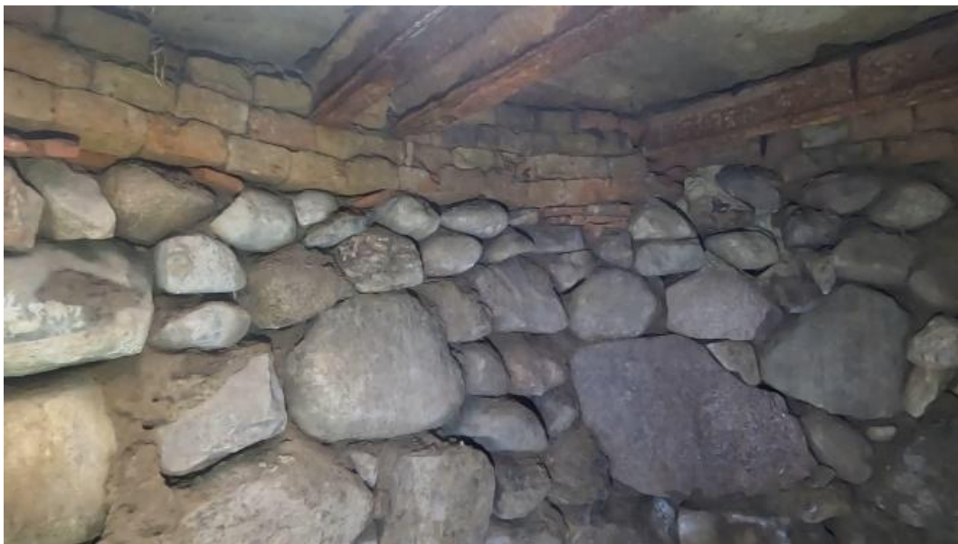
Die Abdeckung des Brunnens vor der Öffnung (Mai 2023). Mehrere Feldbahnschienen trugen die Last der Betonabdeckung mit der darauf installierten Schwengelpumpe (Foto: Maik Römhöld)
