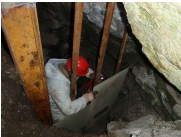
Langsam nimmt der Schachtausbau Formen an (Foto: Dirk Seifert)
