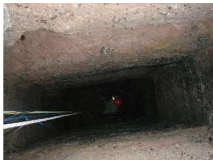
Der Blick von oben in die Tiefe zeigt das typische Schachtprofil (Foto: Dirk Seifert)
