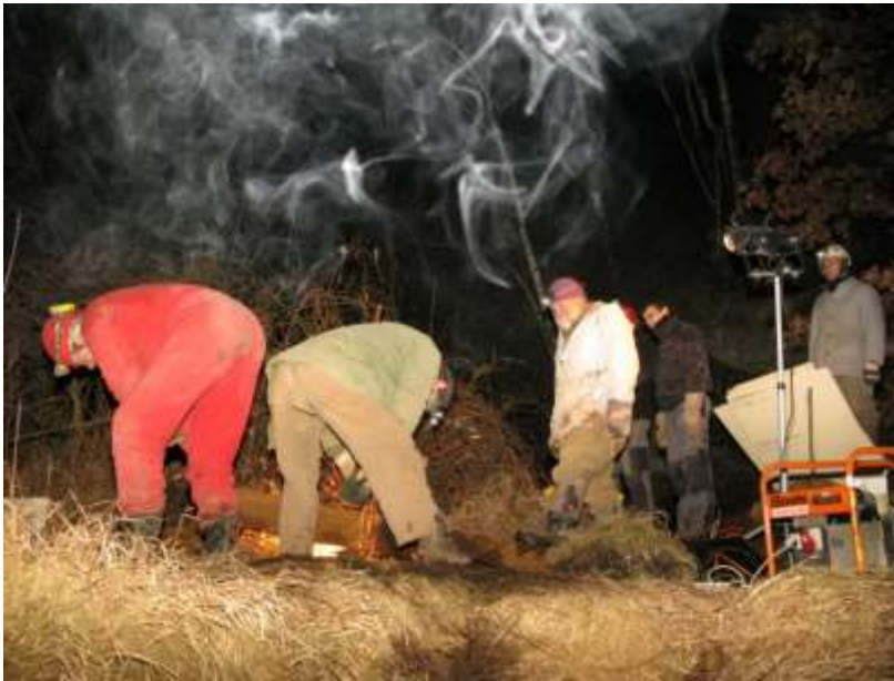
Messen, Schneiden und Schweißen. Die Arbeiten gehen bis in die Nacht (Foto: Michael Brust)
