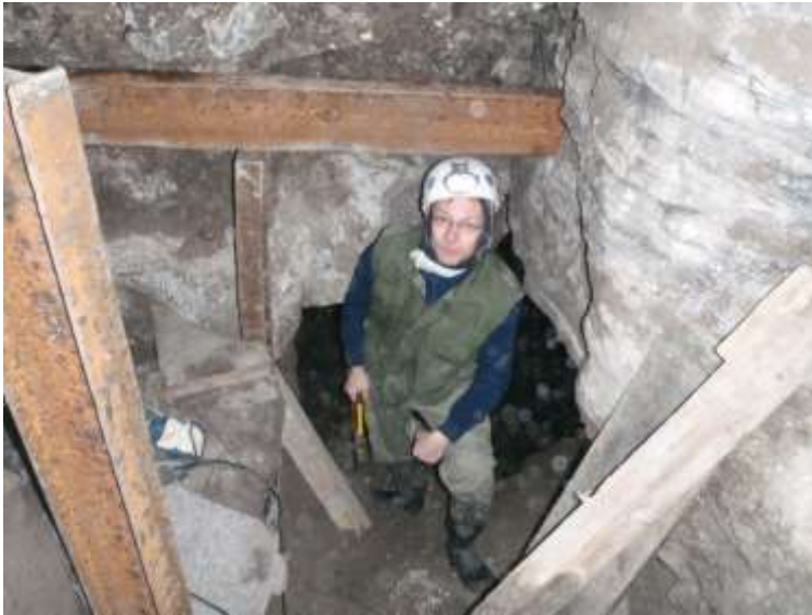
Die ersten Stahlträger sind eingebaut (Foto: Falk Thieme)
