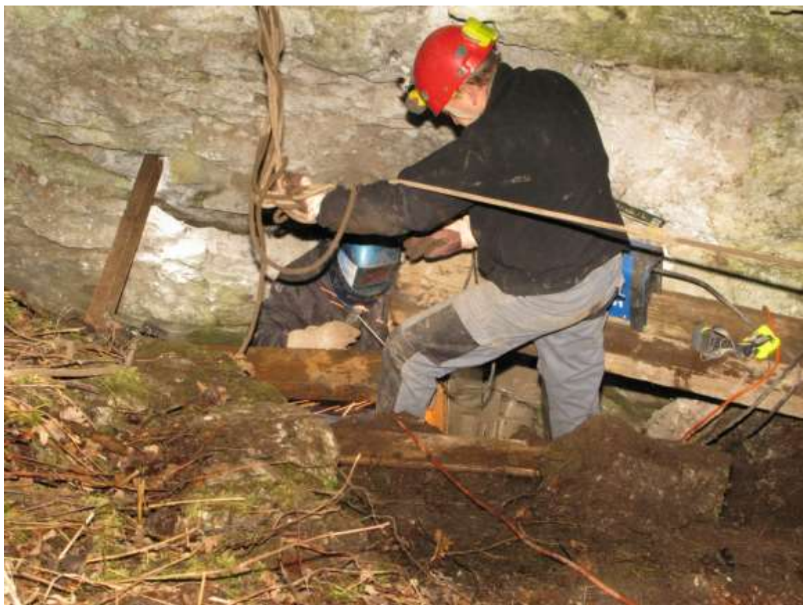
Unsere Schweißer Falk und Philipp Thieme geben dem Stahlausbau und damit dem Schacht an der Numburghöhle die nötige Stabilität. (Foto: Michael Brust)
