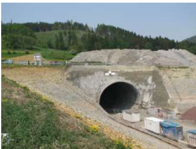
Am Mundloch des Blessberg tunnels (künftige ICE-Strecke, Foto: Hartmut Simmert)
