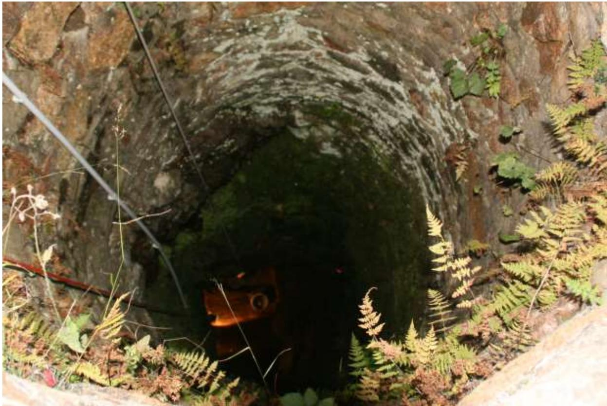
Blick in die Zisterne. Der Querschnitt im unteren Bereich ist fast rechteckig wie ein Bergbauschacht und die Röhre ist leicht geneigt. Der Stahlkübel gleitet unter lautem Gepolter an der schrägen Wand in die Tiefe. Die Sohle kann von oben schon kaum noch eingesehen werden.
