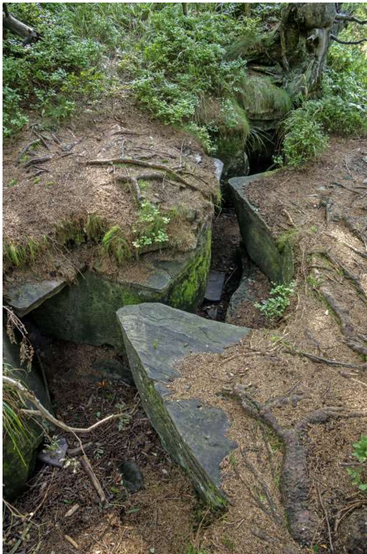
Eine typische Abrisskluft, hervorgerufen durch das Abrutschen großer Teile des Massivs. (Foto: Olda Jenka)
