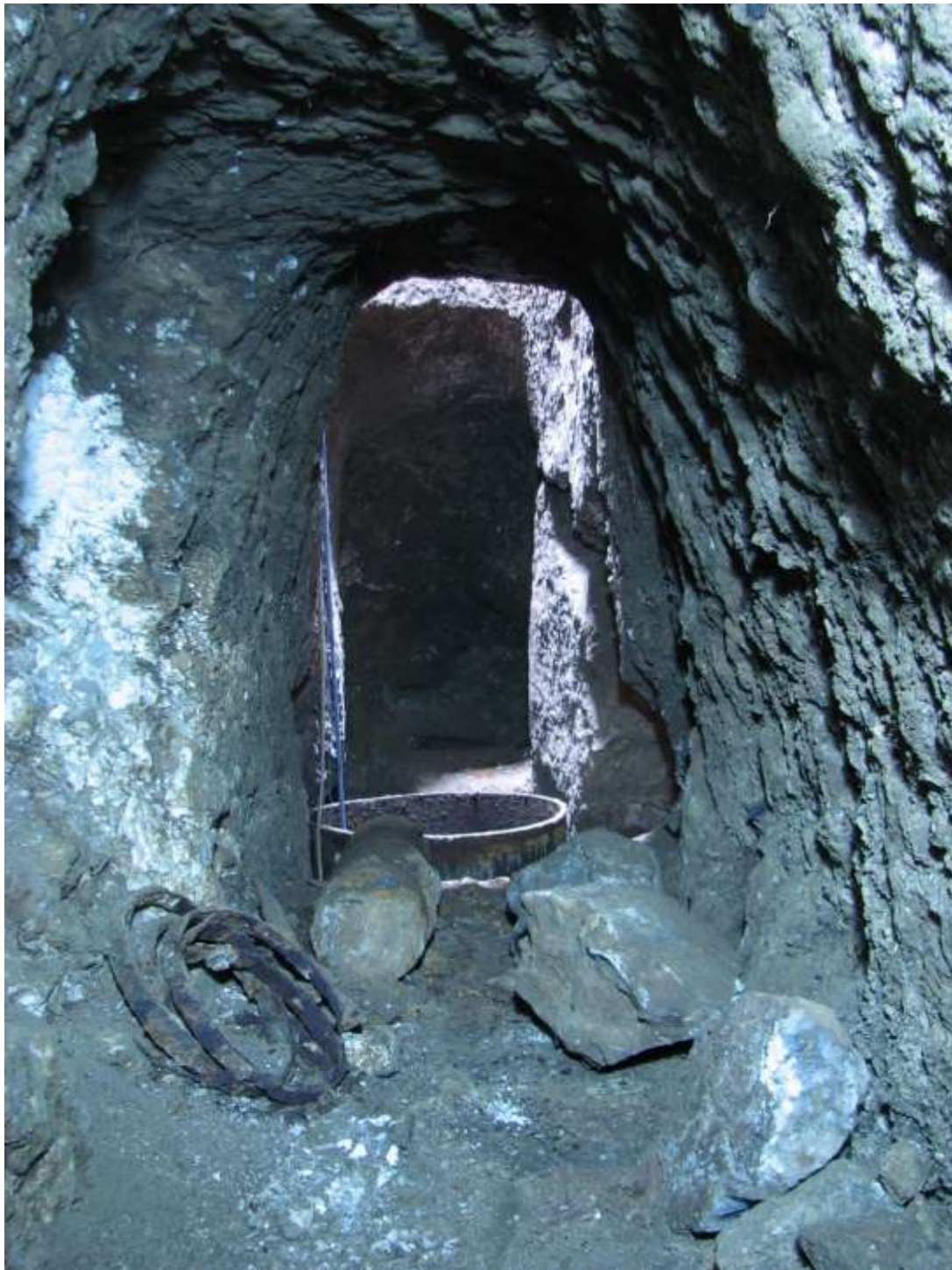
Blick von der Oberen Rösche zum Reginaschacht. Vor dem Schacht liegt auf der linken Seite die alte Pumpe mit einigem Zubehör. (Foto: Hartmut Simmert)
