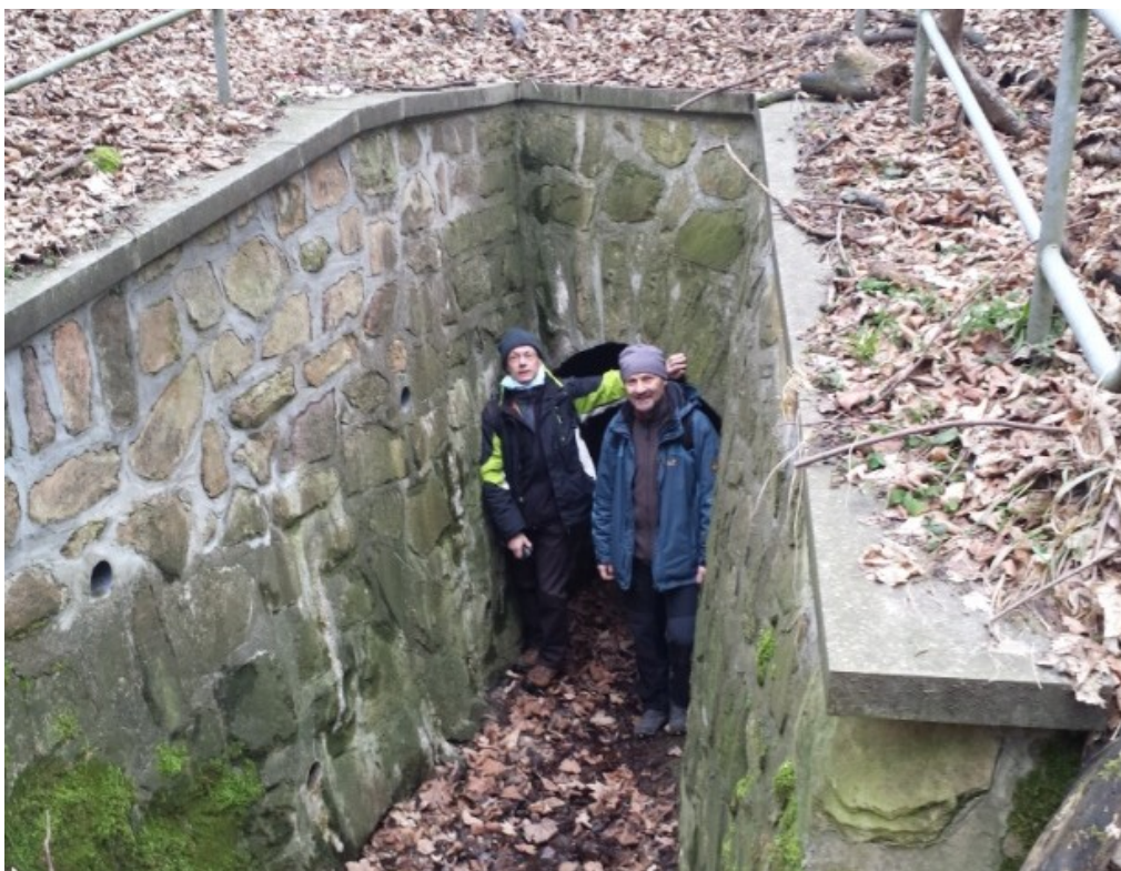
Am Mundloch einer Bahndamm-Rösche im Zschopautal (Foto: Hartmut Simmert)
