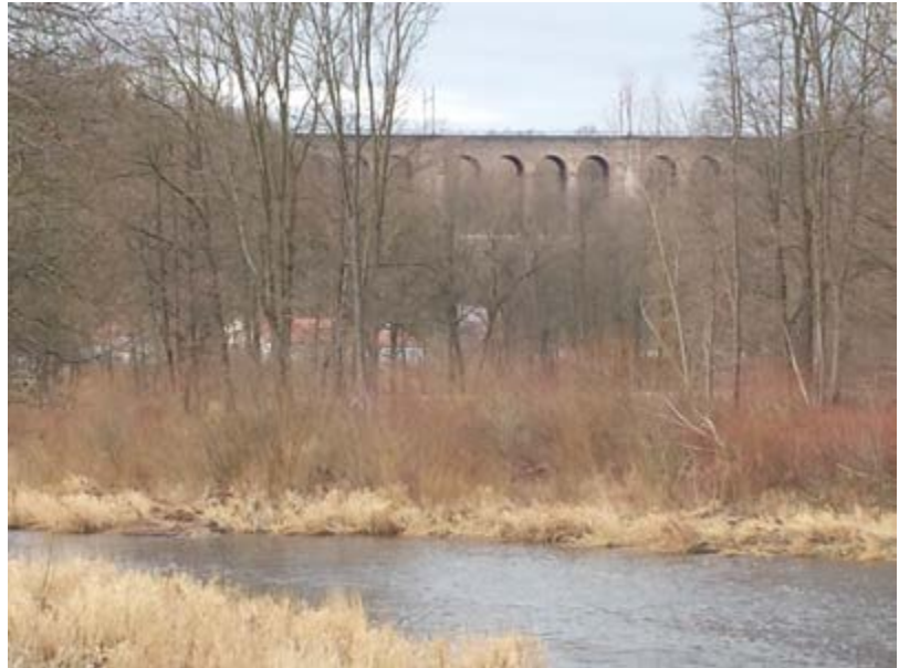
Eines der imposanten zweigleisigen Viadukte, die aus Bruchsteinmauerwerk errichtet wurden (Foto: Hartmut Simmert)
