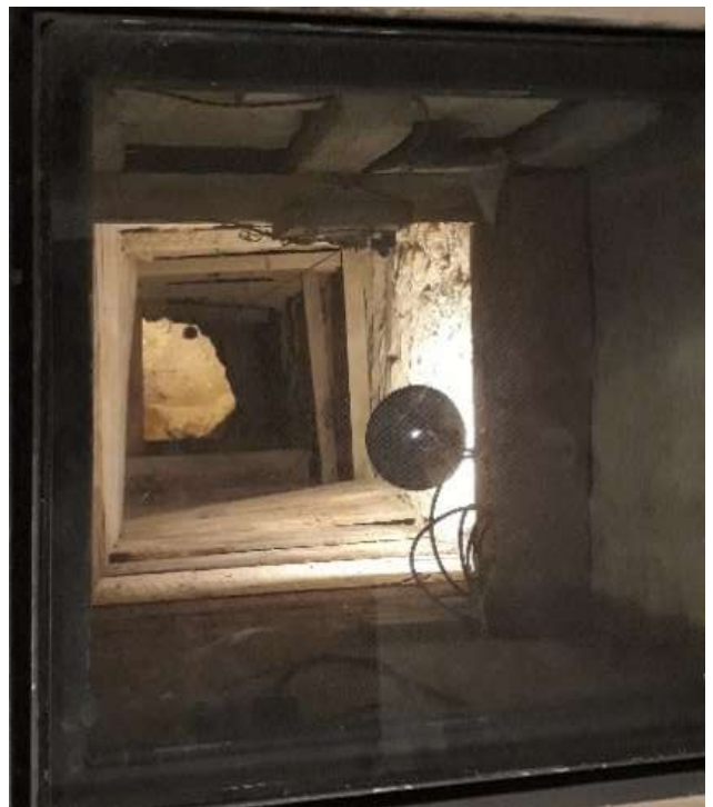
Blick in einen Fluchtschacht, der mit primitiven Werkzeugen gegraben wurde
