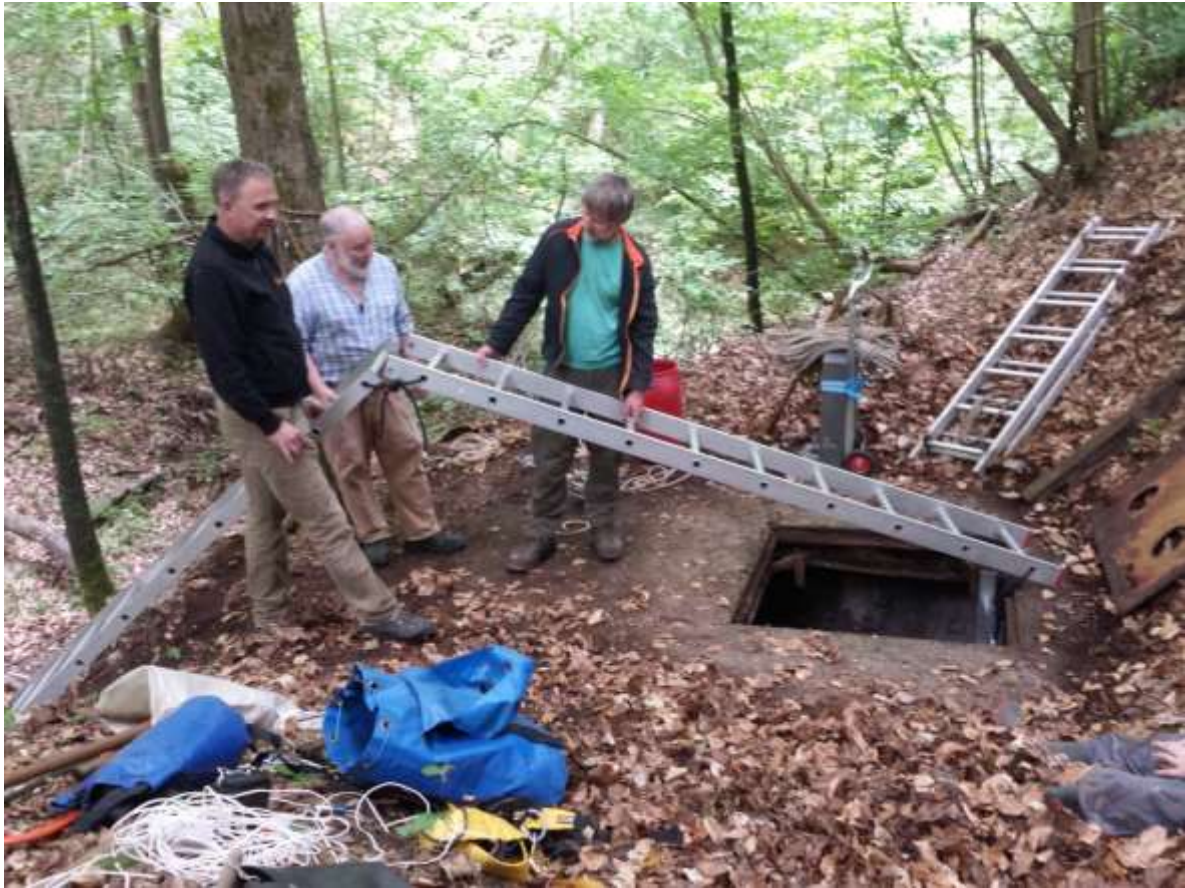
Im Reginaschacht (Südharz) werden Alu-Leitern eingebaut (Foto: Hartmut Simmert)
