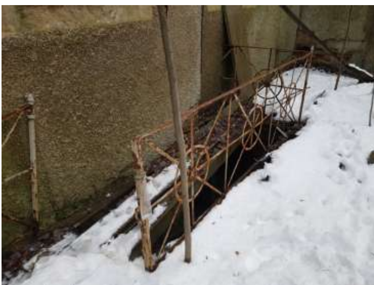
Verschütteter Eingang zum Stolln
