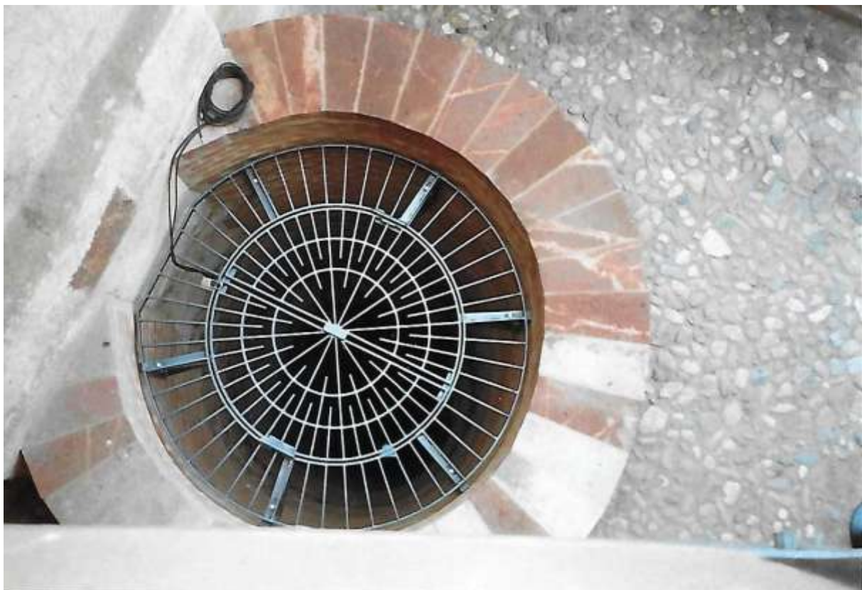
Blick auf den sanierten Burgbrunnen Mildenstein vom Wehrgang aus (Foto: Bernd Wutzig)
