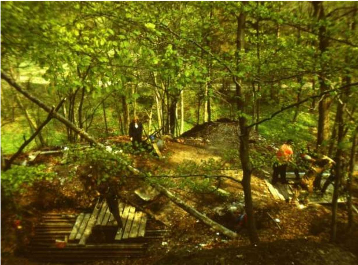
*Situation 1986 am Josefschacht bei Uftrungen: Links der Schacht ist mit einem verschweißten Gitter aus Feldbahnschienen gesichert. Noch liegen wegen der Trittsicherheit Bretter auf dem Schacht, diese werden anschließend durch eine Abdeckung aus stabilem Streckmetall ersetzt, die Befahrungsöffnung erhält eine Klappe aus Stahl. Rechts ist der manuelle Haspel an einem Baum angeschlagen, die Haspelknechte stehen auf einem Arbeitspodest.*
