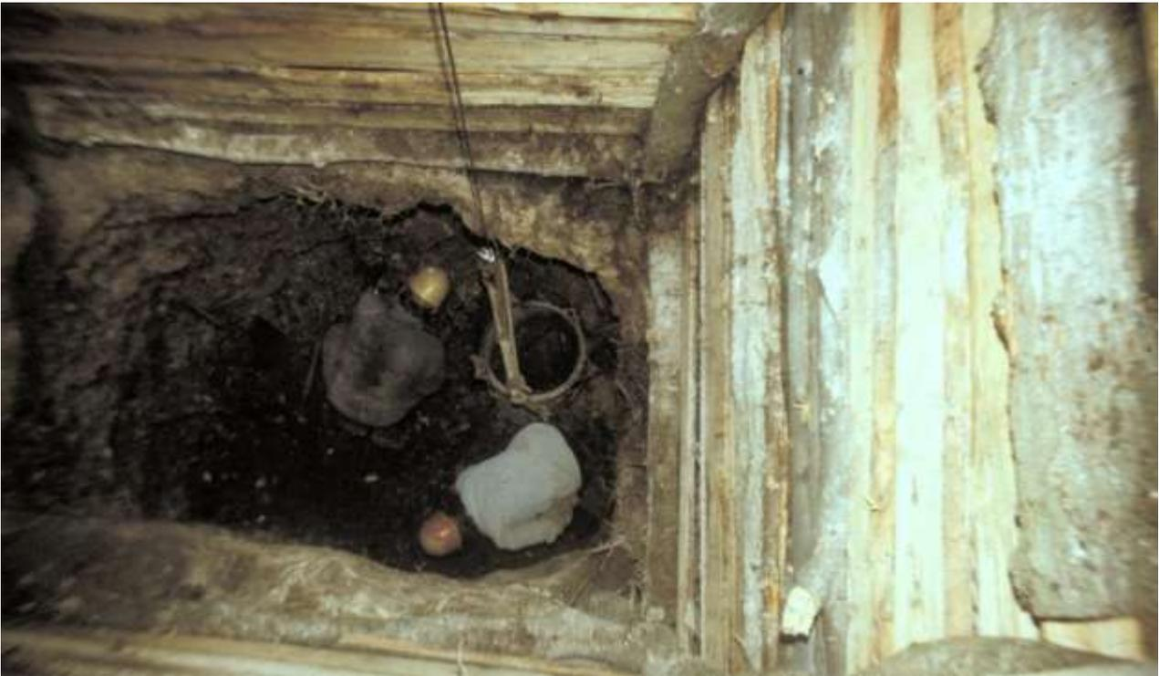
*Der obere Teil des Schachtes ist solide ausgebaut, etwas tiefer finden wir den Schacht mit dem für dieses Bergbaurevier typischen rechteckigen Querschnitt*
